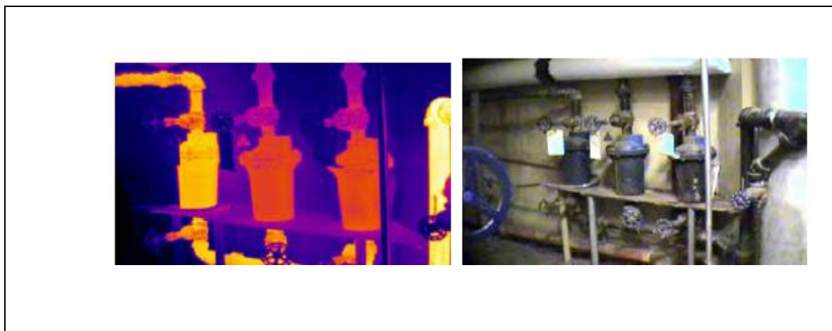
شکل (۴-۸): بررسی وضعیت عملکرد والوها و تله های بخار
